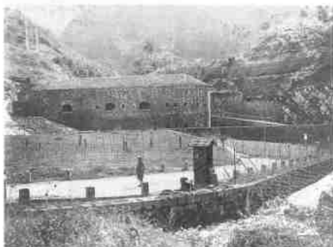
Blocco stradale al Bus de Vela
