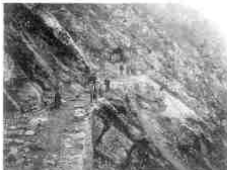
Costruzione della strada Aldeno-Valle di Cei
