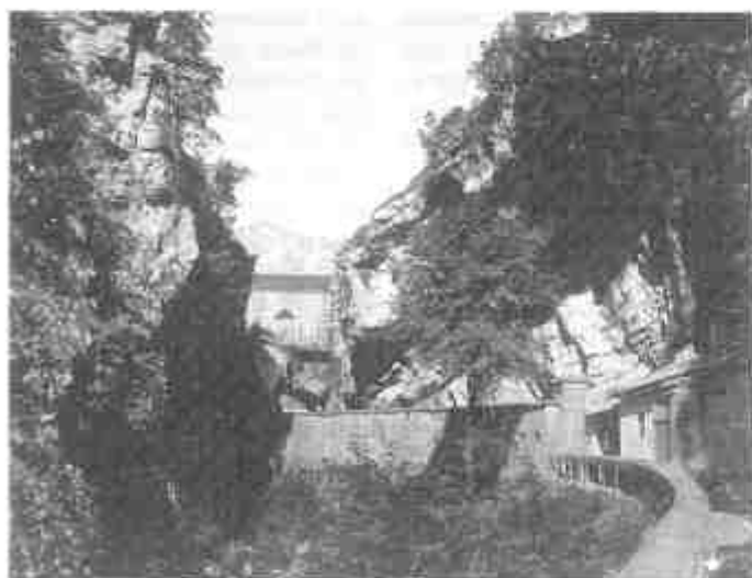
Blocco stradale al Bus de Vela
