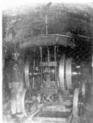
Motogeneratore al Bus de Vela
