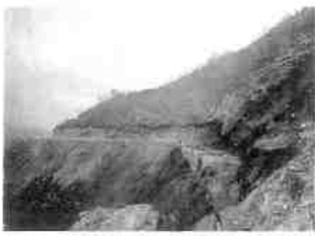
Costruzione della strada Aldeno-Valle di Cei
