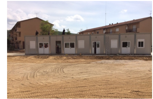
05.09.2016 - posa dei moduli
