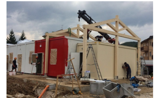
10.09.2016 - inizio lavori tetto in legno
