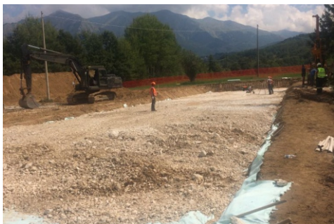
01.09.2016 - la posa dello stabilizzato
