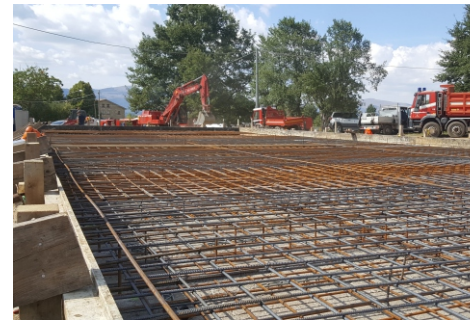
02.09.2016 - l'armatura della platea
