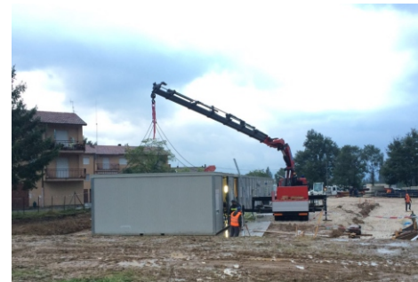
07.09.2016 - continua la posa dei moduli
