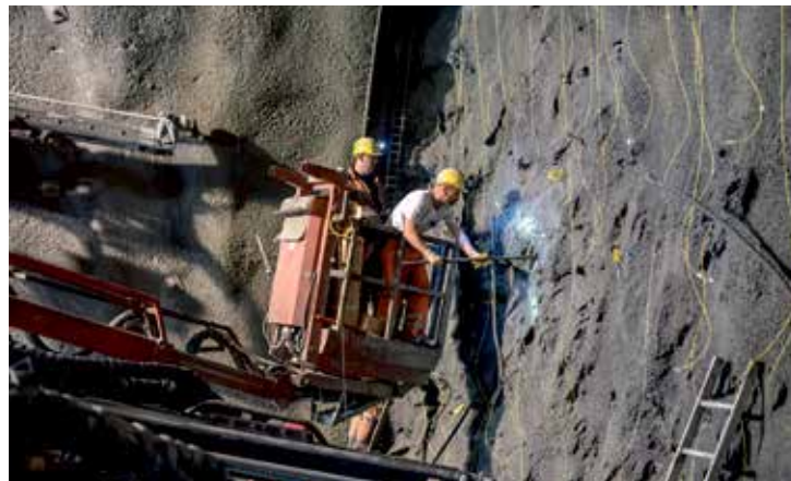
Meter für Meter arbeiten sich die Mineure durch das Brennermassiv Metro dopo metro lo scavo avanza nel cuore della montagna.
