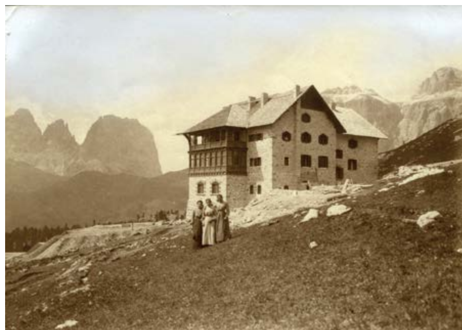
Albergo al passo Pordoi (Canazei, Val di Fassa), 1904
