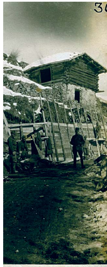
Costruzione di una strada militare a Palù Palai (Archivio Luciano Dellai)
