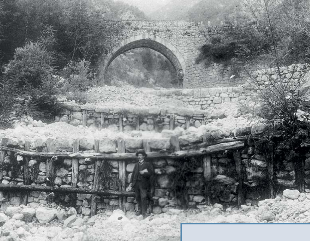
Sopra: briglie ottocentesche in castagno; a sinistra: briglie austroungariche e una moderna briglia a Vermiglio
