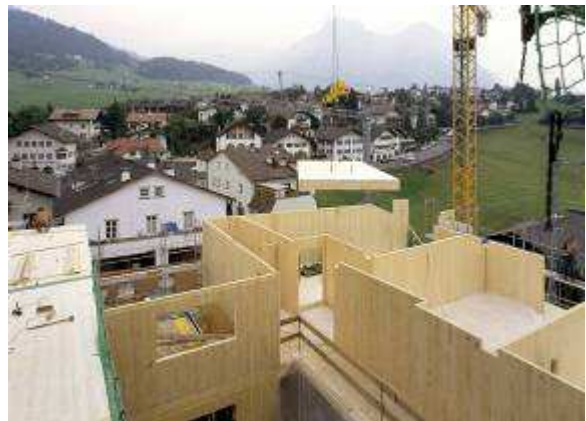
Realizzazione di un edificio con struttura portante in x-lam
