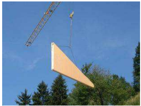
Pareti assemblate sul posto
