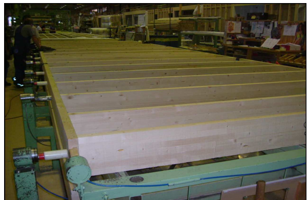
Alcune fasi dell'assemblaggio delle pareti
