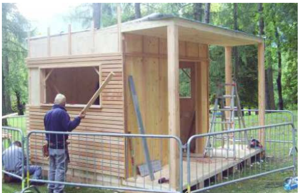
Alcune fasi di montaggio (settembre 2011)
