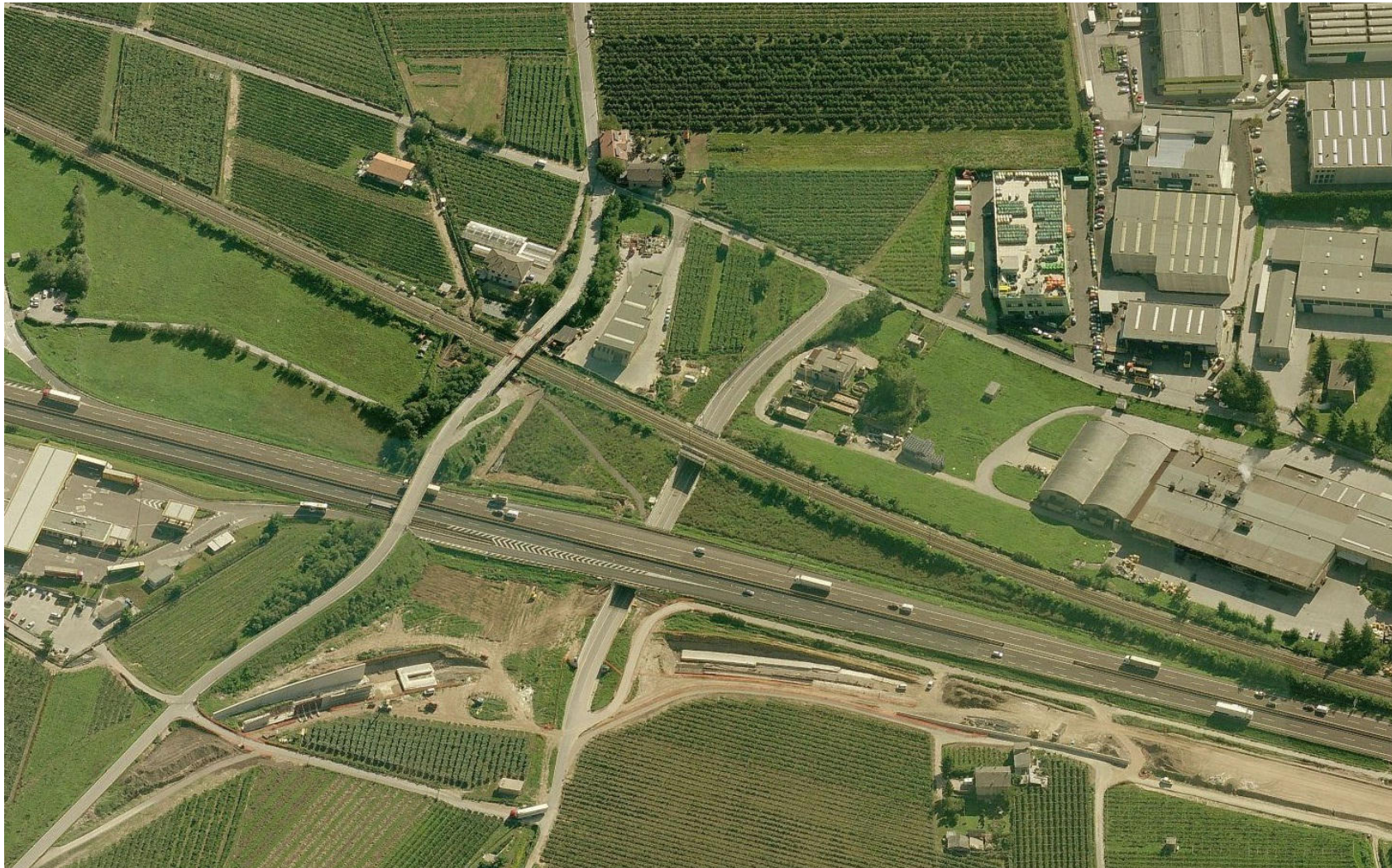
Vista aerea dell'area durante la fase di costruzione della circonvallazione (fonte Bing Maps)
