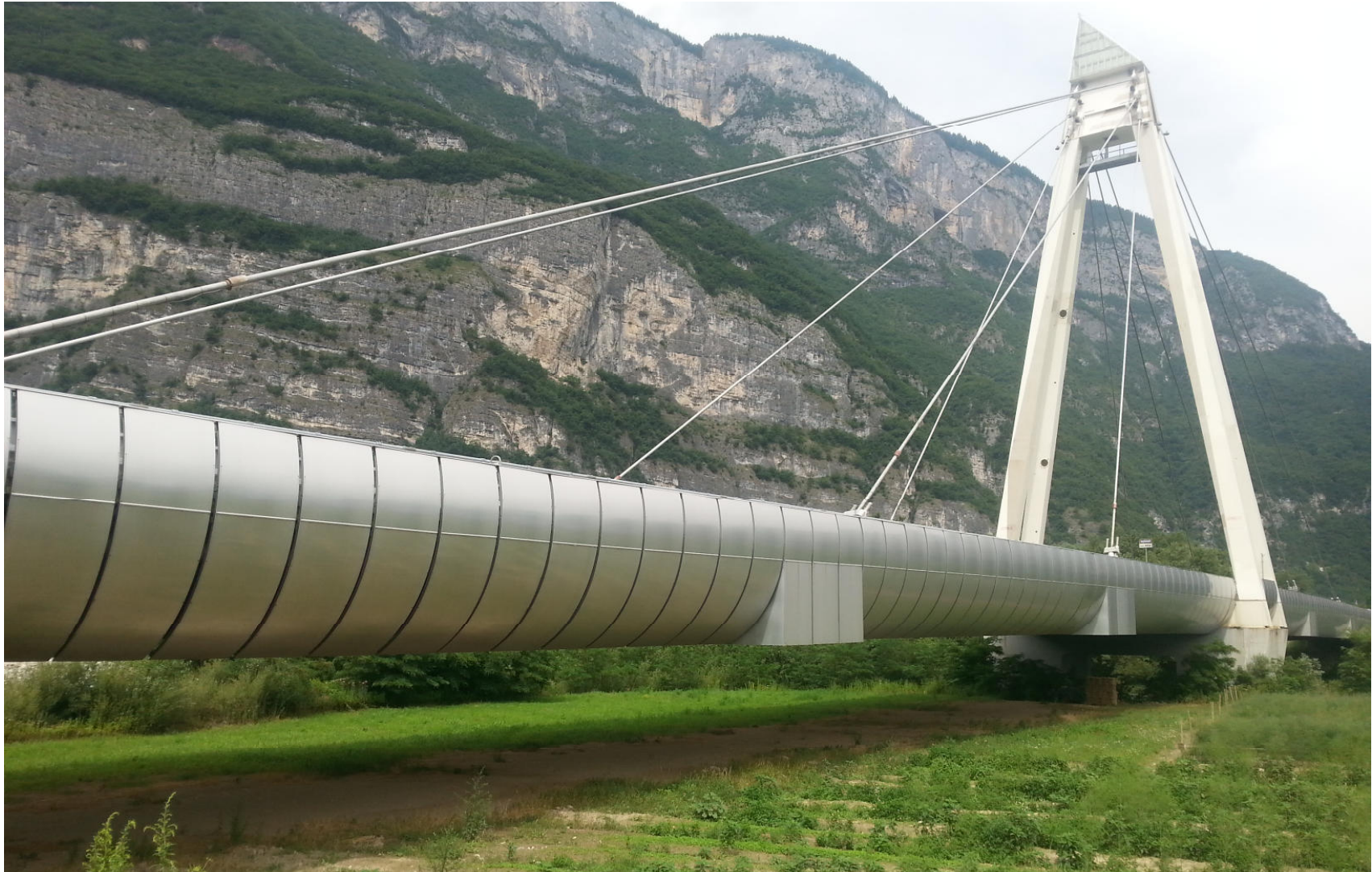
Stato attuale della porzione di area posta sotto il ponte
