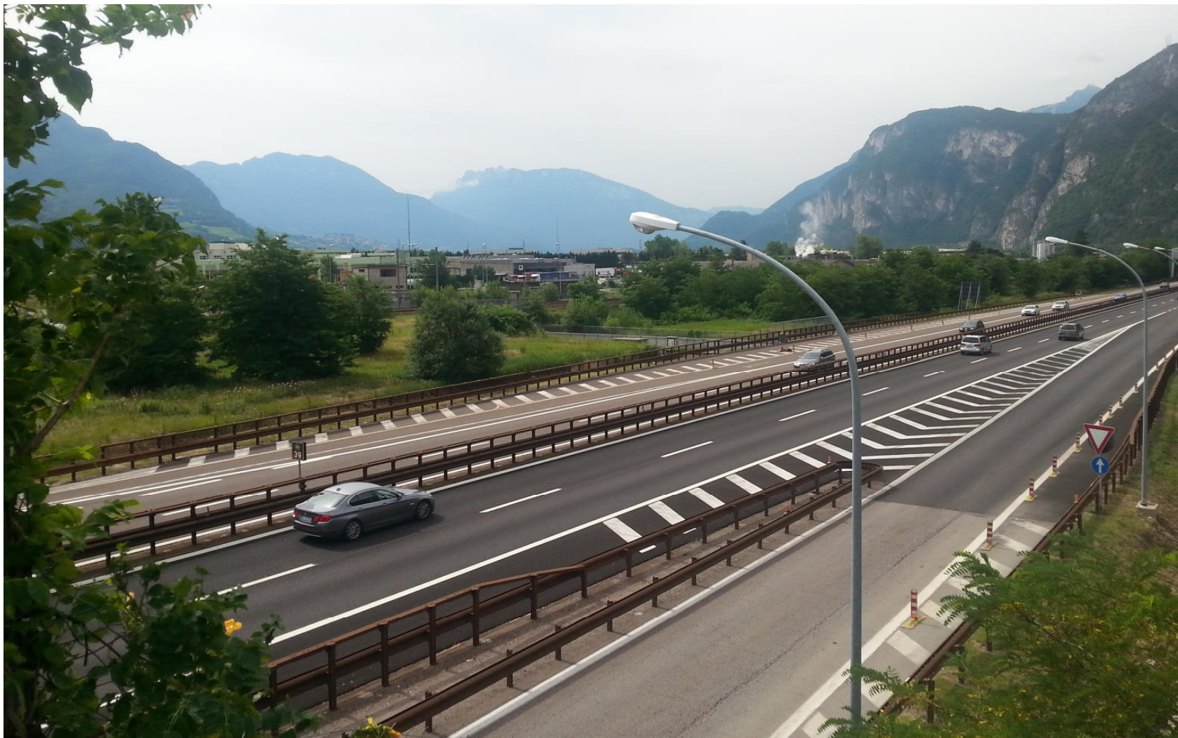
Vista dell'area dal cavalcavia sull'autostrada
