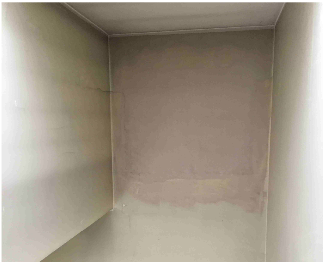
Foto 5: tamponamento finestra al piano attico
