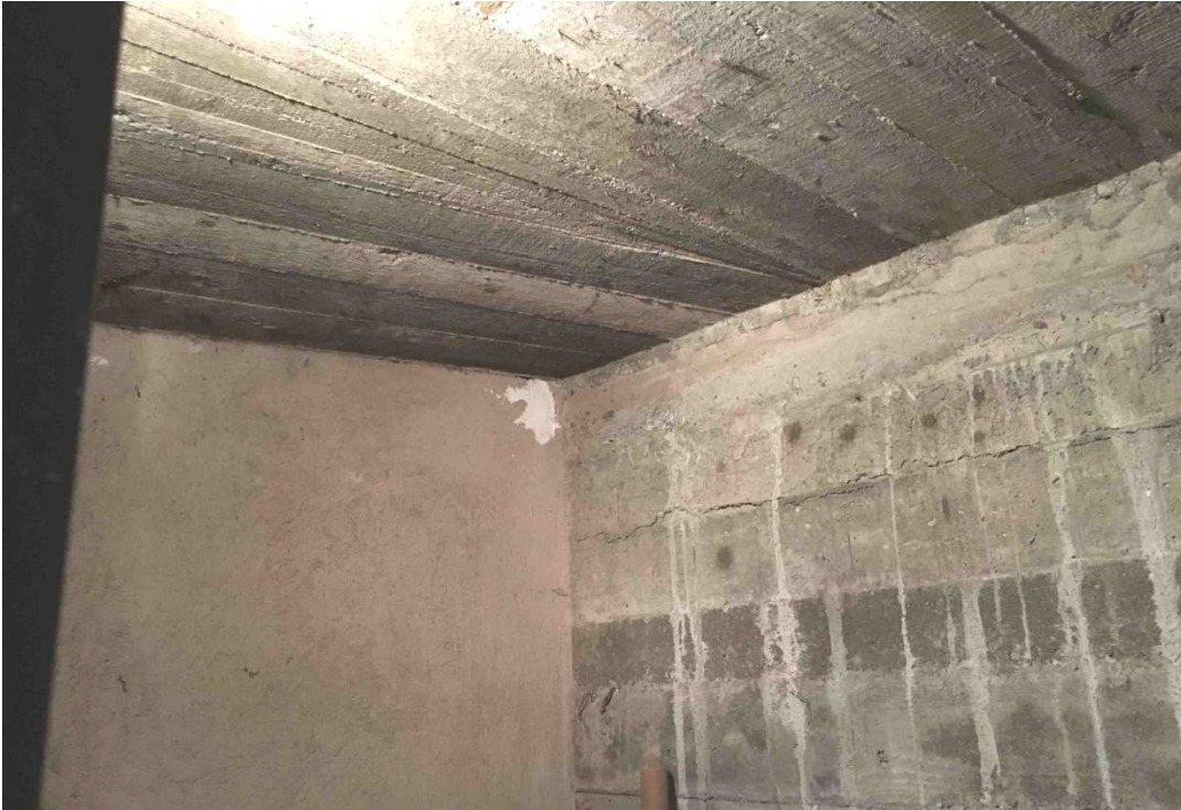
Foto 2: particolare rampa scale in cemento armato
